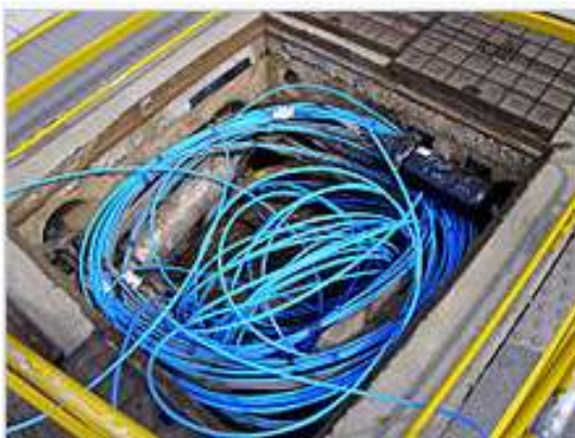
Polaganje optičkog kabla u podzemne instalacije
